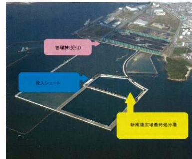
徳山下松港新南陽広域最終処分場 (山口県 HP)
